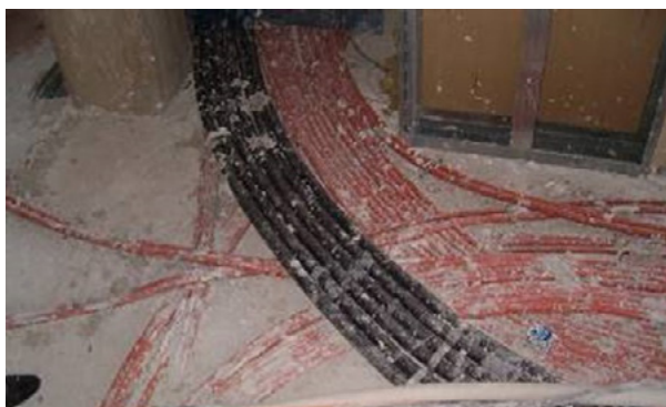
16-17. ábra: A födémen futó vezetékek takarásához kiegyenlítő esztrich tervezése szükséges (fotók: Sántha B.)
