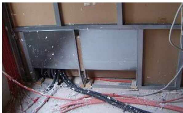
16-17. ábra: A födémen futó vezetékek takarásához kiegyenlítő esztrich tervezése szükséges (fotók: Sántha B.)
